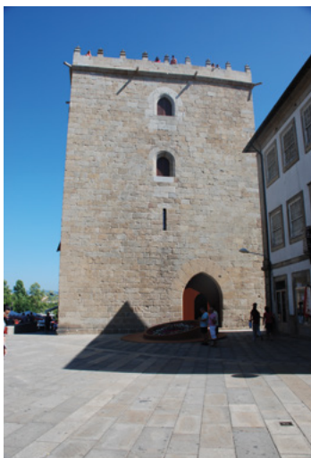
Torre da Porta Nova (Barcelos)
