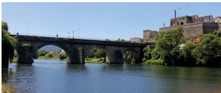
Ponte medieval sobre o Cávado (Barcelos)
