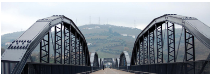
Ponte metálica (Peso da Régua)
