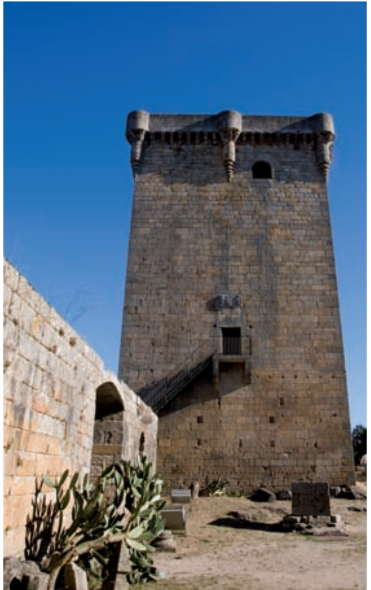
Torre da Homenaxe. Monterrei
