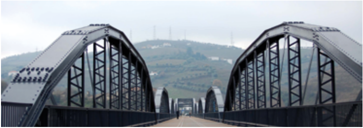
Ponte metálica (Peso da Régua)
