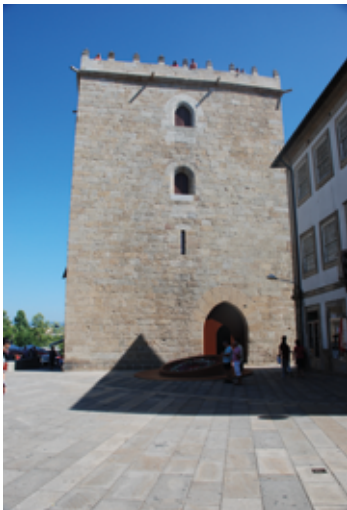
Torre da Porta Nova (Barcelos)
