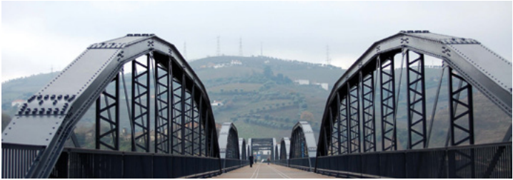
Ponte metálica (Peso da Régua)
