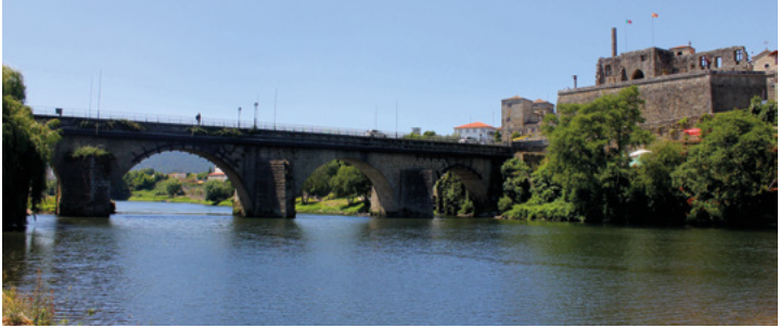
Ponte medieval sobre o Cávado (Barcelos)
