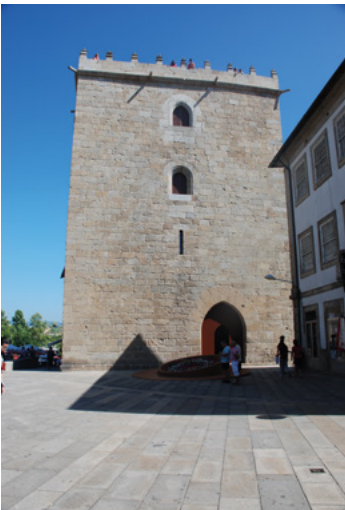
Torre da Porta Nova (Barcelos)
